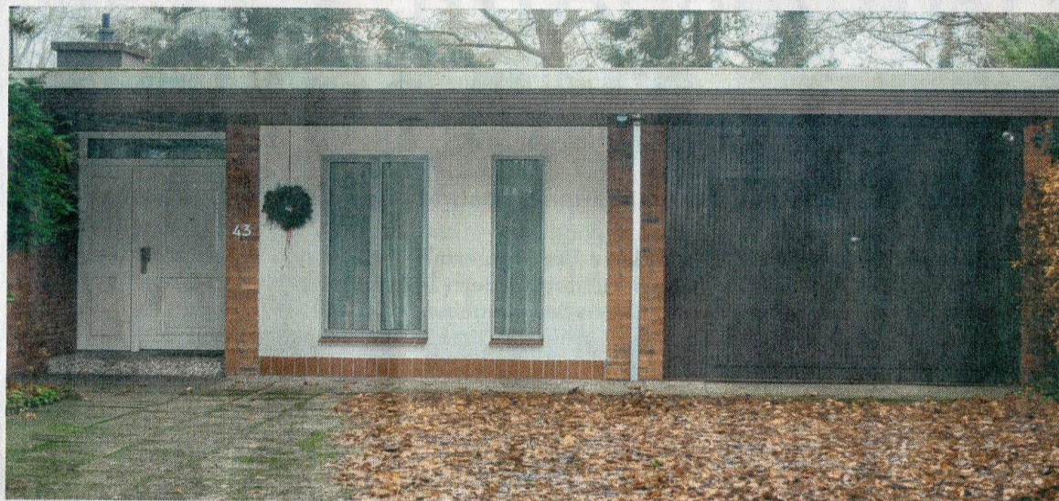
Bungalow im Morgennebel: 67 Häuser dieser Art wurden in Quickborn gebaut. FOTO: ERDBRÜGGER
