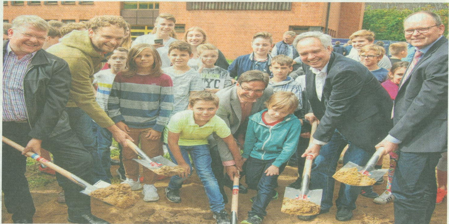
Christian Lück vom Planungsbüro (von links), Hauke Meyn (CDU), Thomas Köppl, Architekt Peter Oschkinat und Schulleiter Michael Bülck haben gestern gemeinsam den ersten Spatenstich vorgenommen. ELLERSIEK
