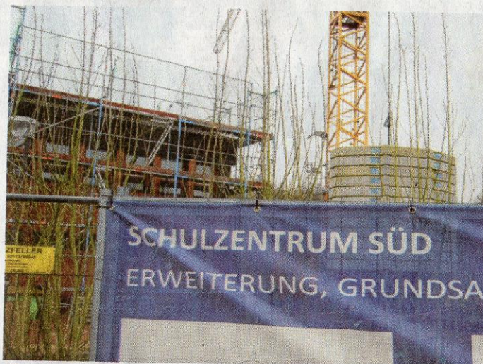
Eingerüstet und zur Großbaustelle mutiert: Das Schulzentrum-Süd wird erweitert und saniert. FOTO: ELLERSIEK
